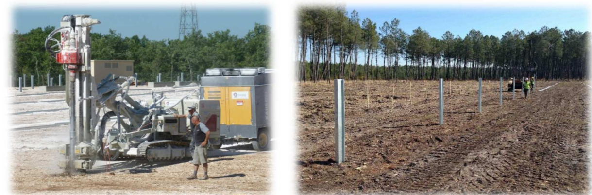
Ancrage au sol par pieux battus
